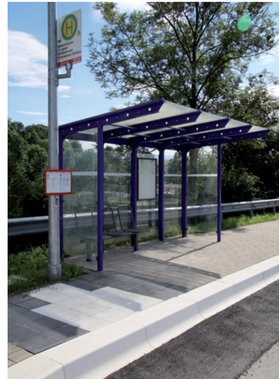
Nur mit Bordhöhen von über 21 cm kann die Reststufe (siehe 3.3.7) so gering gehalten werden, dass Rollstuhlfahrer vollkommen selbstständig ein- und aussteigen können. Bordhöhen von 21 cm und mehr eignen sich vor allem bei aufkommenstarken Haltestellen oder an Haltestellen, die regelmäßig von Rollstuhlfahrern benutzt werden. Ansonsten empfiehlt der VRN den aktuellen Standard von 18 cm.
